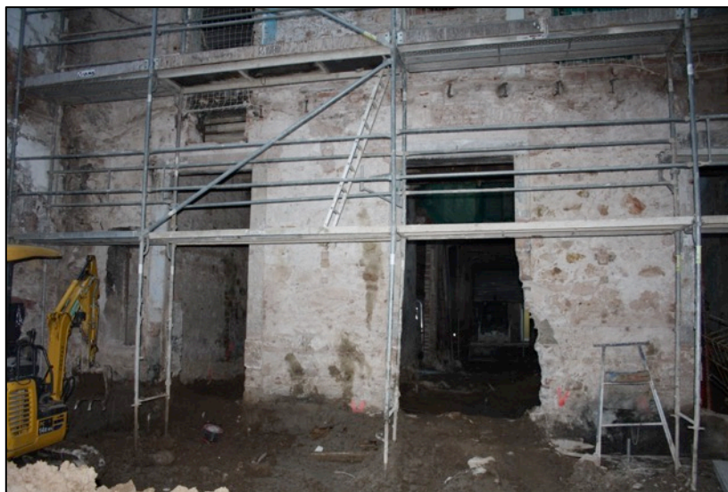
Fotografia 69. Zona exterior finca actual amb vista del mur s. XVIII UE146 en alçat.
