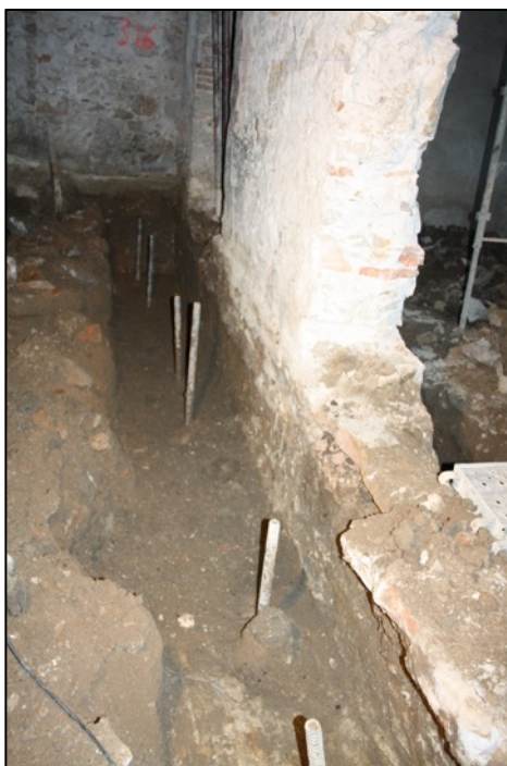
Fotografia 80. Vista general rasa 2 un cop realitzat el rebaix.
