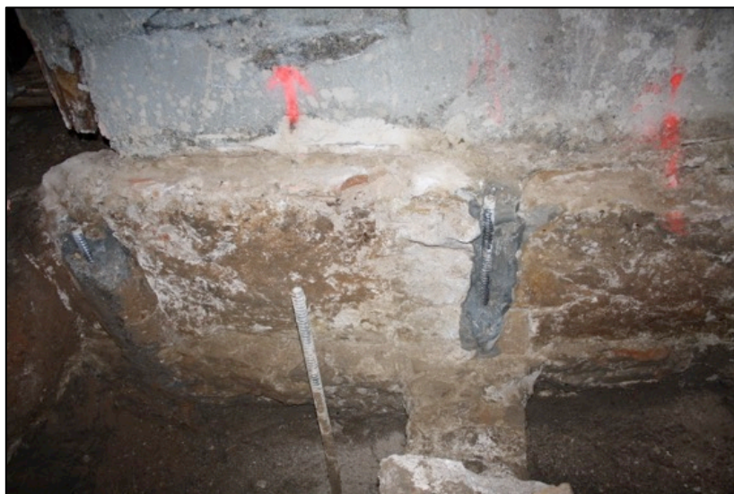
Fotografia 48. Vista de l'alçat cara sud mur s. XVIII UE180.
