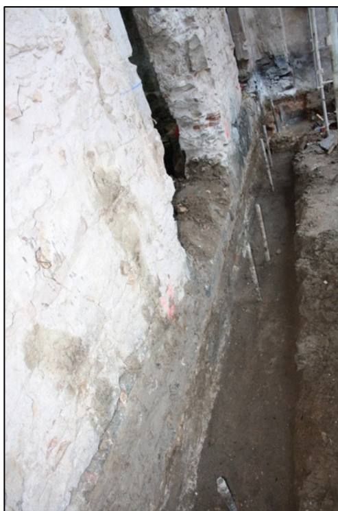
Fotografia 74. Vista general del mur UE146.
