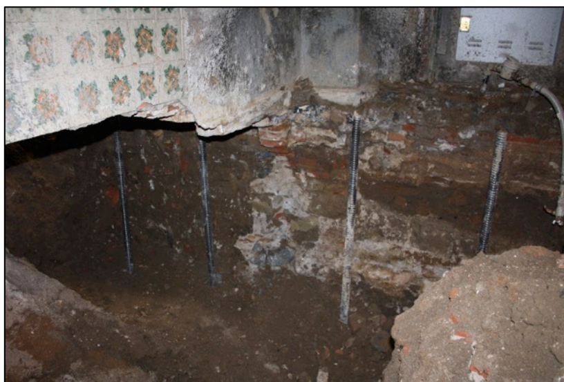
Foto 64. Vista general encep 15 un cop acabat el rebaix pertinent.
