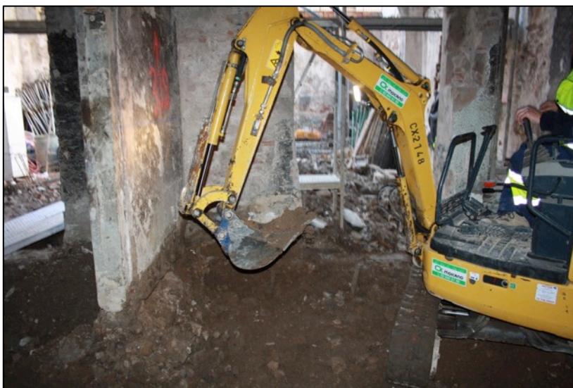
Fotografia 76. Rebaix nivell contemporani UE158.
