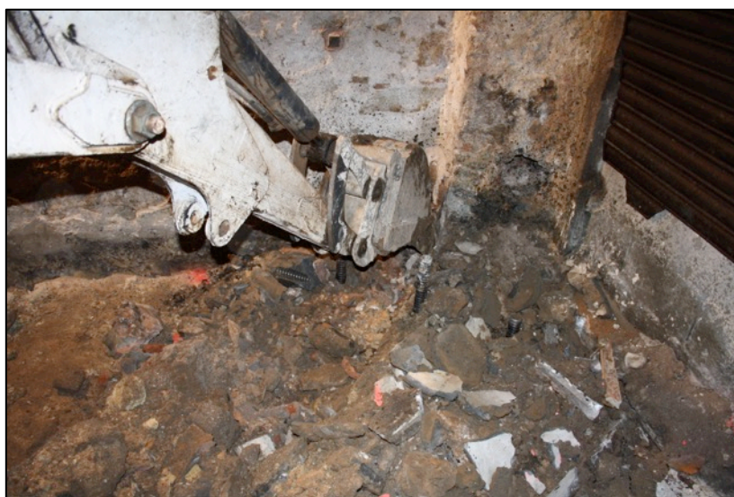
Fotografia 51. Rebaix estrat de runa contemporània UE185.
