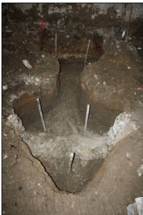
Fotografia 15. Vista general dels rebaixos fets als encepat 2 i 5.
