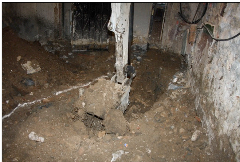
Fotografia 65. Rebaix nivell contemporani UE202.
