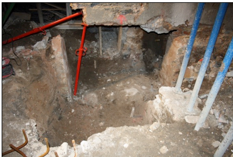
Fotografia 49. Vista general encepant 9 un cop desmuntats murs UE180 i UE184.
